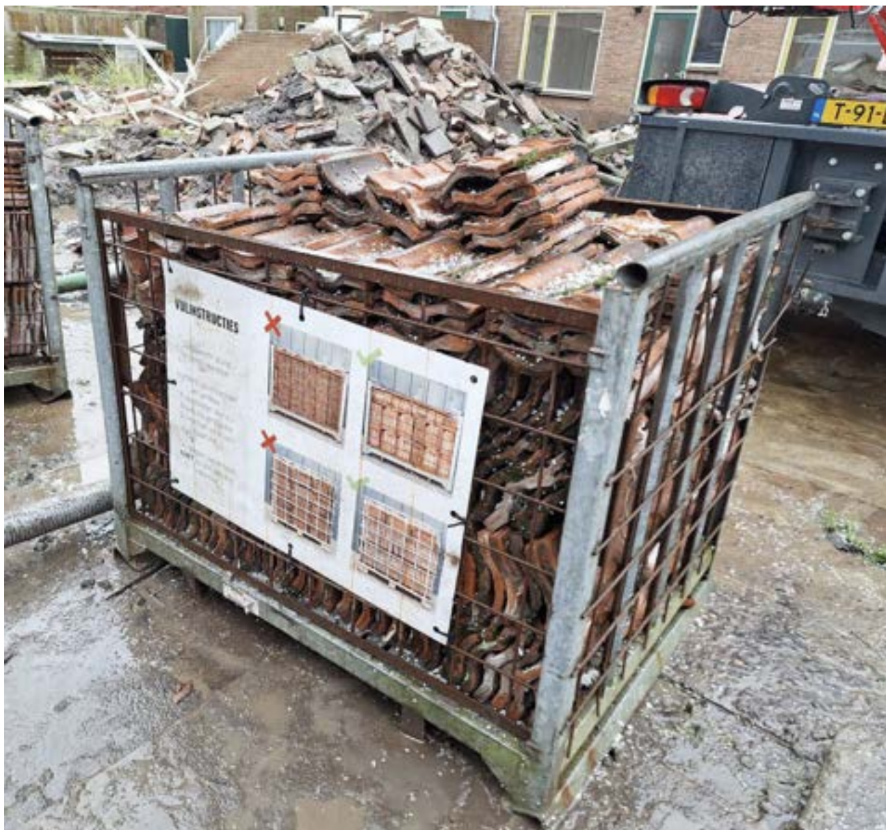
Dakpannen kunnen goed worden geoogst voor hergebruik.
